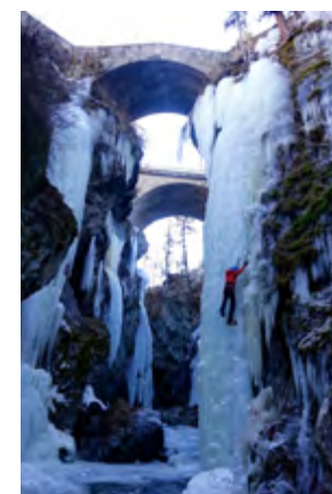
Alte und neue Brücke über die Schlucht Flaz bei Pontresina mit Eiskletterer
