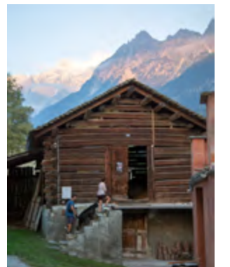
Scheune hinter dem Schloss und der Rimessa Castelmur
